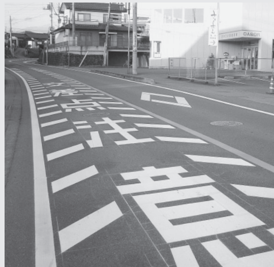
国道406号：ドラッグスギ前(写真左・中)、県道群馬八幡(停)剣崎線：さくらホール北側(写真右) 死亡事故も発生し、危険な横断箇所を町内会・県・県警・市とともに現地調査を実施。安全対策として路面に安全表示を行った。特に国道406号は信号設置についても要望中。
