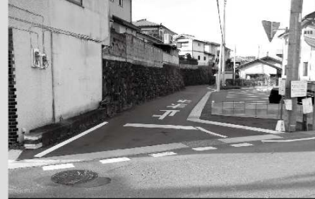
地元・柴田和正市議と協力し、八幡1区・4区公民館から道を挟んだ西向かい側の市道を拡幅。出入りが容易に。
