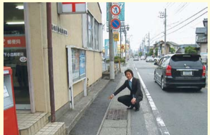
県道高崎榛名吾妻線 歩道の未舗装部分を(下小鳥郵便局～カインズホームの区間)を解消して、安全に歩行できるように改良
