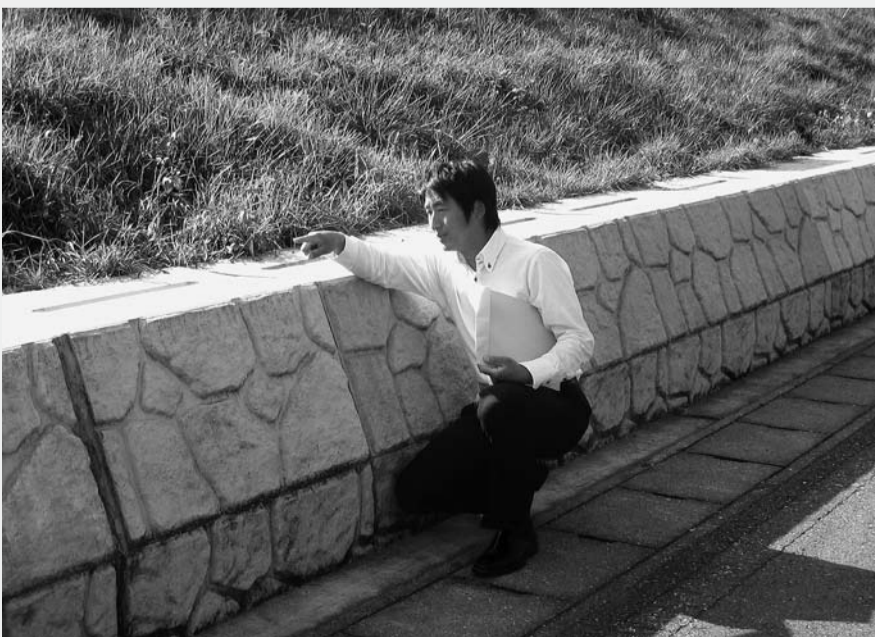
要望を受け、現地の状況を確認する後藤かつみ
