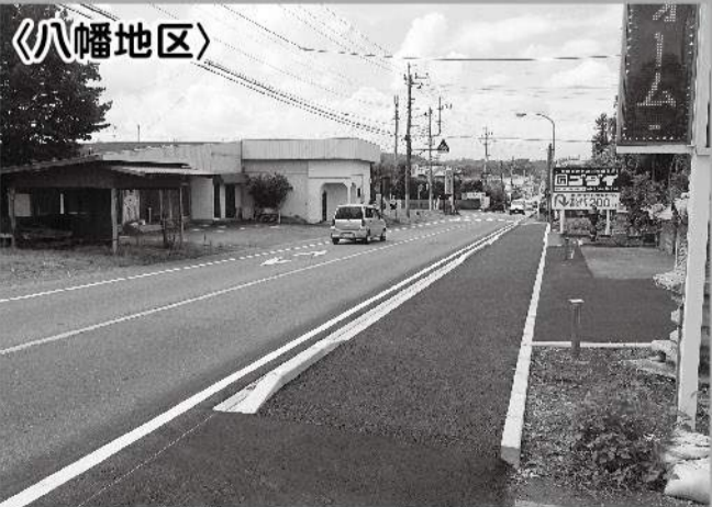
〈八幡地区〉 西部小学校の通学路安全対策として、八幡霊園南側の歩道の拡幅事業を実施しました。
