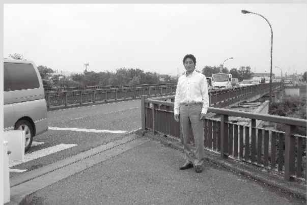
長年の懸案であった町屋橋の拡幅工事について、いよいよ今年度に事業が本格化。右岸側(町屋側)を拡幅することで、交通混雑の緩和が期待される。
